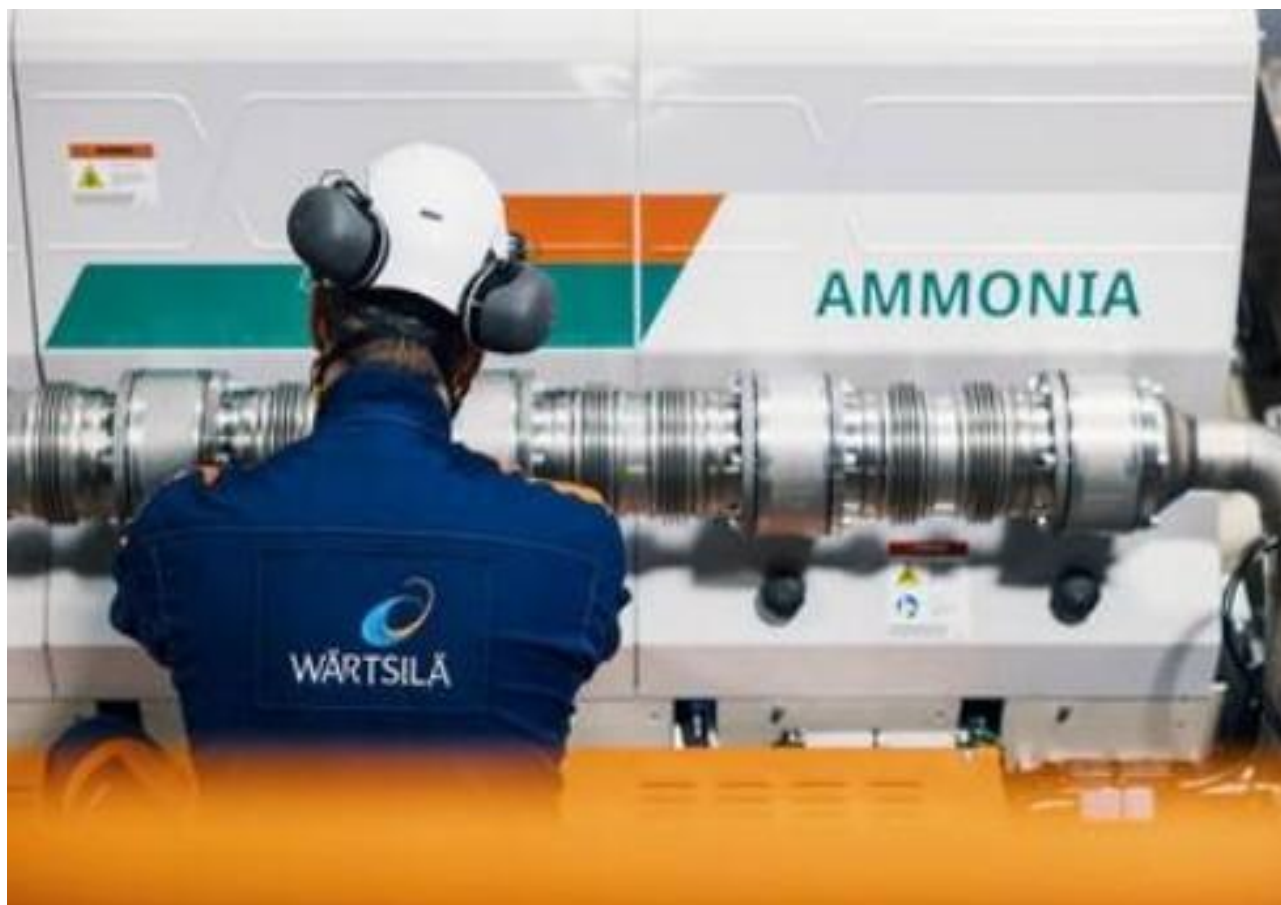
Slika: Wärtsilä testiranje cjevovoda za dovod amonijaka kao goriva
