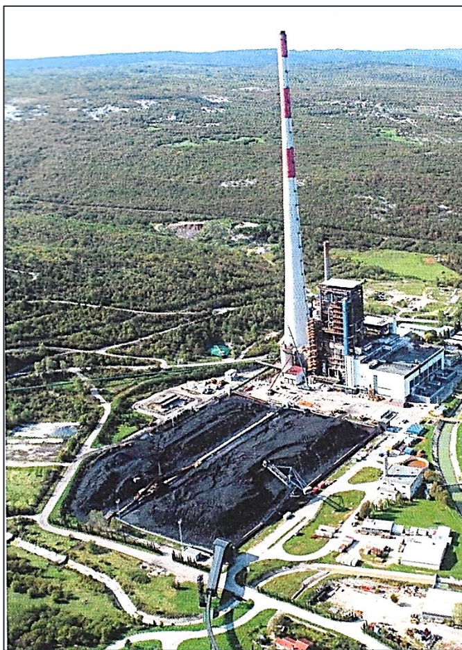
Novo DeNox postrojenje na plominskoj lokaciji
