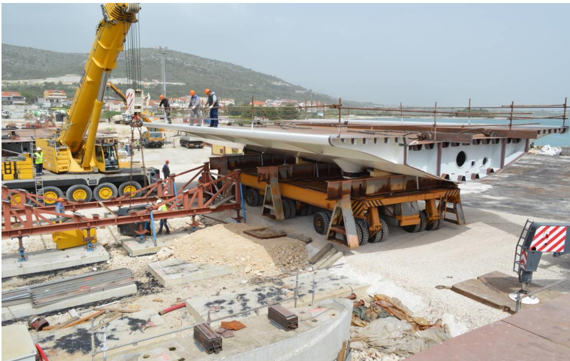
Postavljanje čelične sekcije mosta – Picture credits: brodosplit.hr
