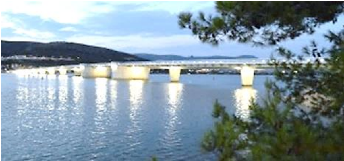
Novi most za Čiovo – Picture credits: brodosplit.hr
