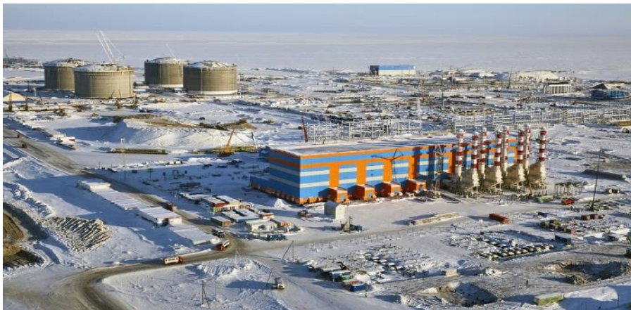
„Yamal LNG“ postrojenje: Lijepo se vide 4 skladišna LNG tanka i 4 uređaja za ukapljivanje te mnoga vozila po cesti – Picture credits: Total S.A.
