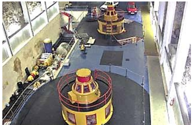
Unutrašnjost podzemne strojarnice HE Plat Autor Mmarre - [1] obnovljivi.com poštena uporaba
