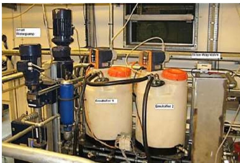
Slika 6: Emulgatorski tankovi s dozirnim pumpama na vrhu. Također se vide i pumpe vode kao i trosmjerni ventili kroz koje se dozira emulgator ili u gorivo ili u vodu
