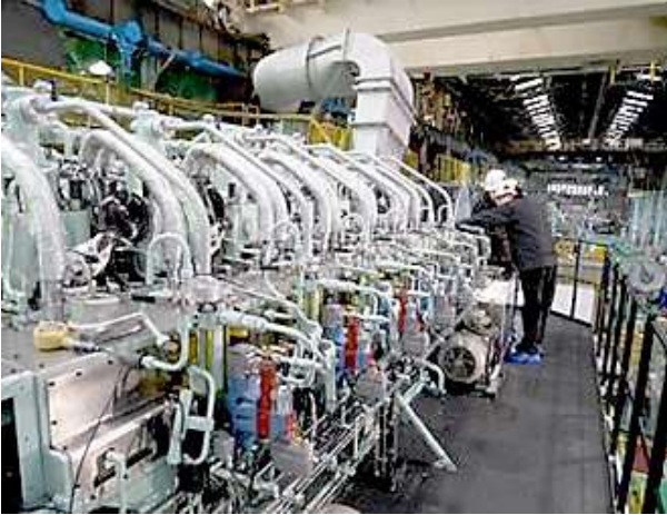
Glavni stroj opremljen s 'common rail fuel injection system' Photo credit: mol.co.jp
