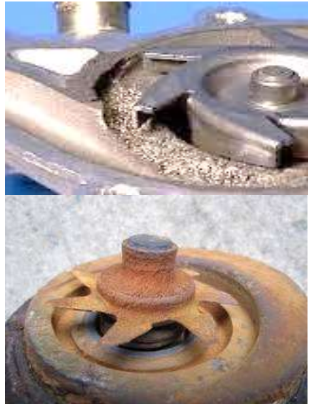
Slika 3 - Oštećenja pumpi rashladnog sustava
