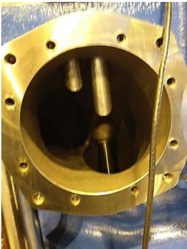
Slika 2 – Cijevi za dobavu plina u cjevovodu prije usisnog ventila
