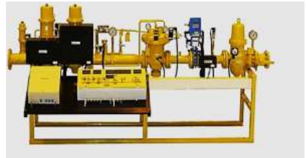
Slika 7. Ventilaska stanica za dobavu plina
