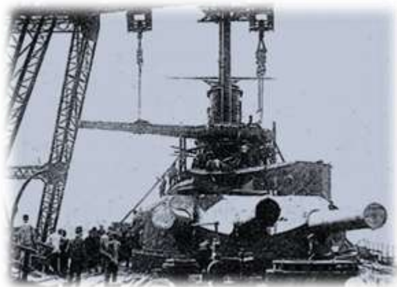
Montaža topa od 305 mm na bojni brod u pulskoj luci
