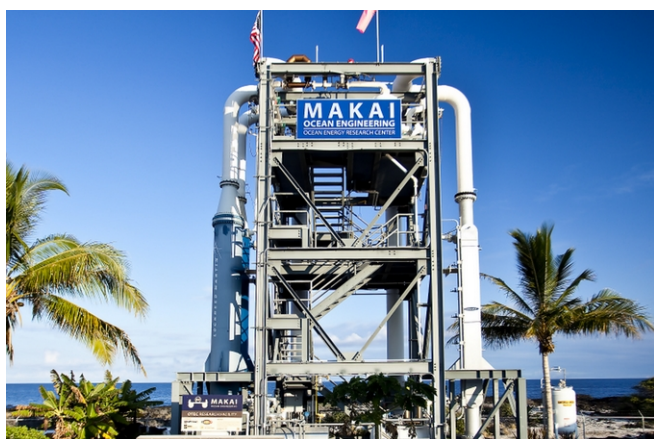
MAKAI OTEC 100 kW kopneno postrojenje Hawaii
