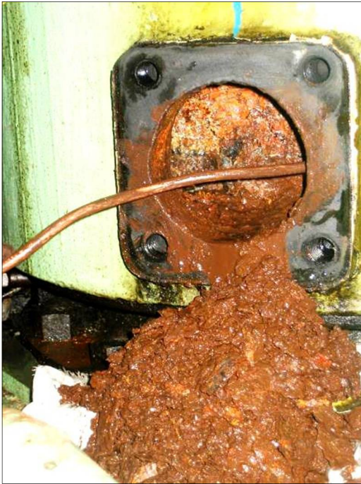
Ulaz rashladne vode u donji dio košuljice. Otkriveno blago korozije, kamenca i taloga
