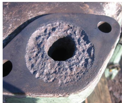
Svi prolazi za vodu s jasnim tragovima korozije
